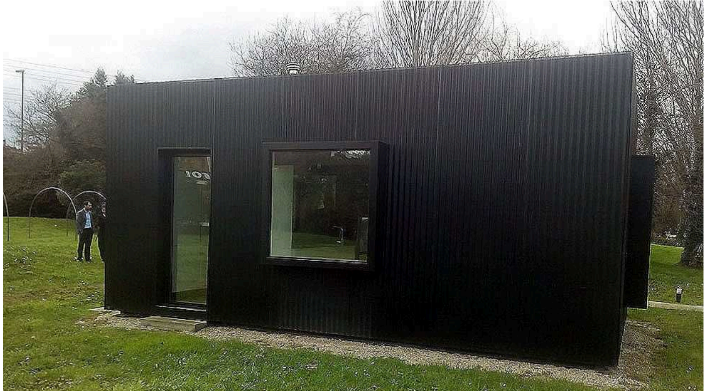
Vivienda modular con acero construida por Arcelor
